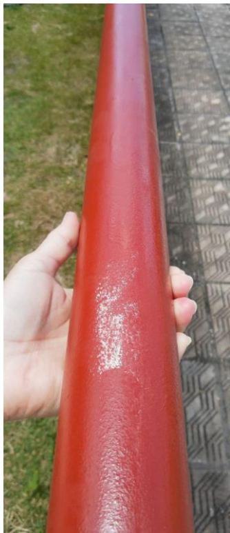
Figura 1: conclusão da pintura das grades da piscina
