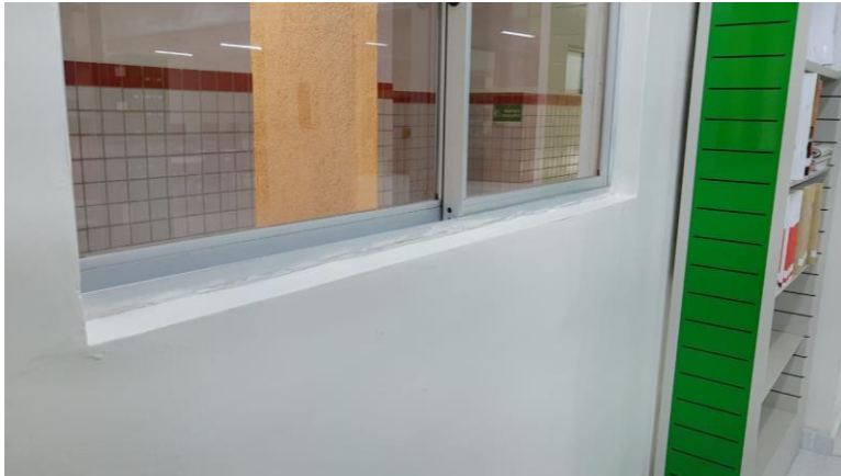
Figura 20: revisão e limpeza geral da pintura na Biblioteca.
