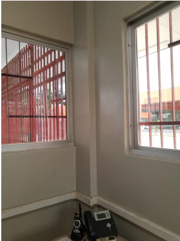
Figura 13: revisão e limpeza da pintura na Guarita.
