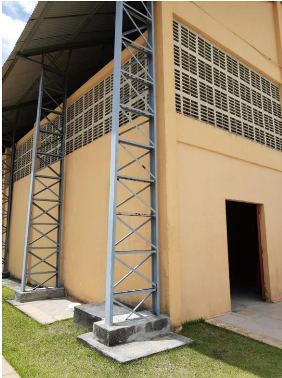
Figura 9: Conclusão da pintura do pilar frontal do ginásio.
