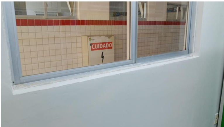
Figura 21: revisão e limpeza geral da pintura na Biblioteca.
