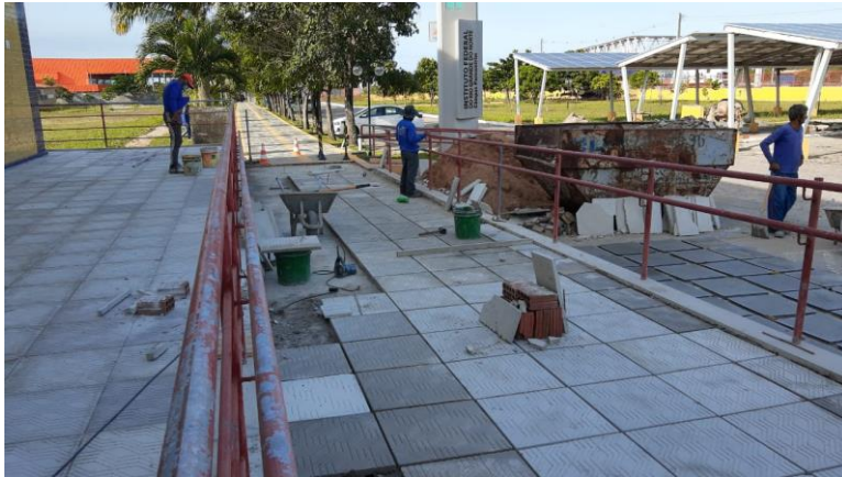
Figura 15: Conclusão do assentamento do piso na entrada do prédio principal
