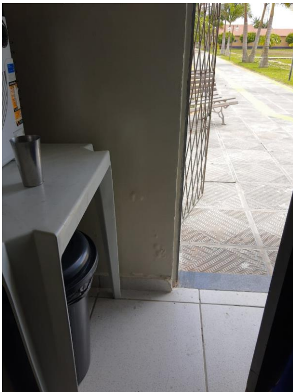
Figura 14: revisão e limpeza da pintura na Guarita.
