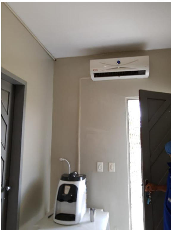
Figura 12: revisão e limpeza da pintura na Guarita.
