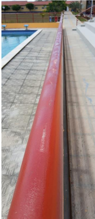
Figura 2: conclusão da pintura das grades da piscina
